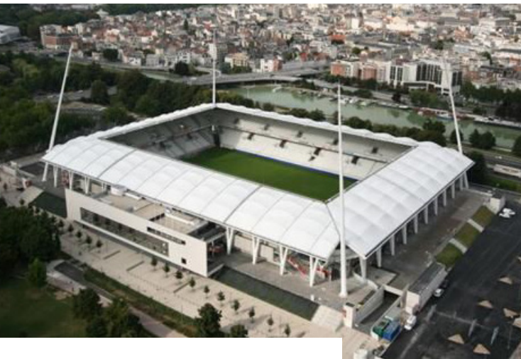
Stade de Reims, il tetto permette alla luce di raggiungere il terreno di gioco
